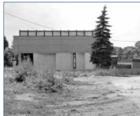
Z archivu Technických služeb města Svitavy - stavba smuteční obřadní síně v roce 1971.
