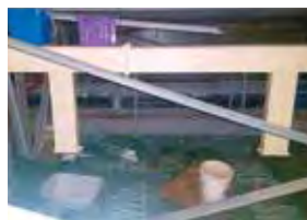
Do konstrukce střechy na mnoha místech zatéká.
