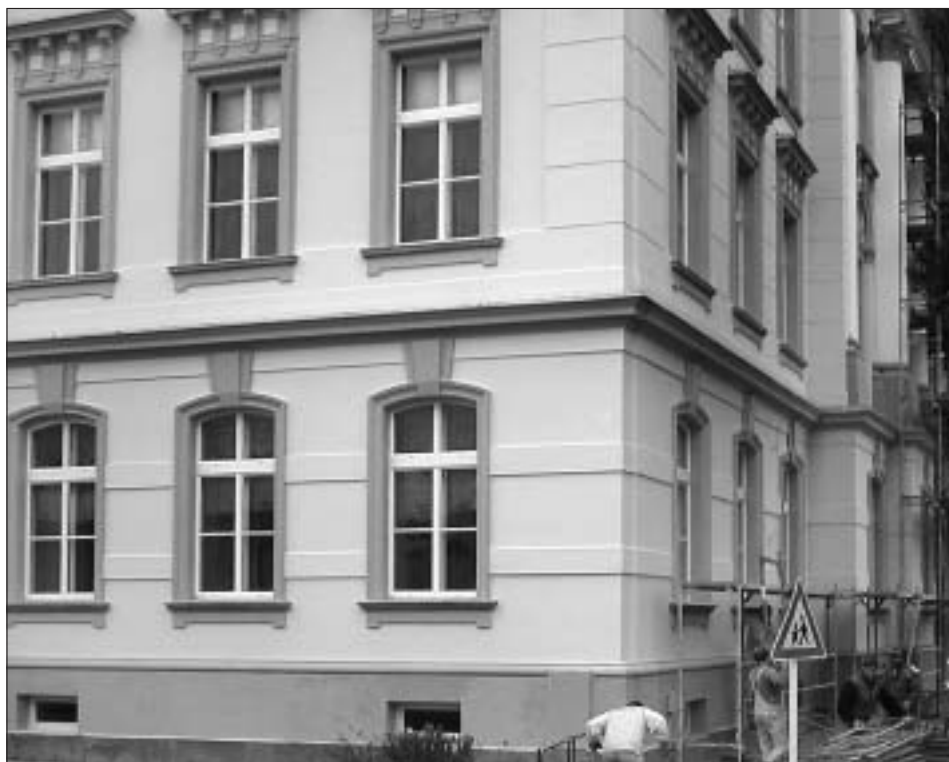
Ve čtvrtek 21. listopadu se do krásy vyloupla fasáda základní školy na ulici T. G. Masaryka.
