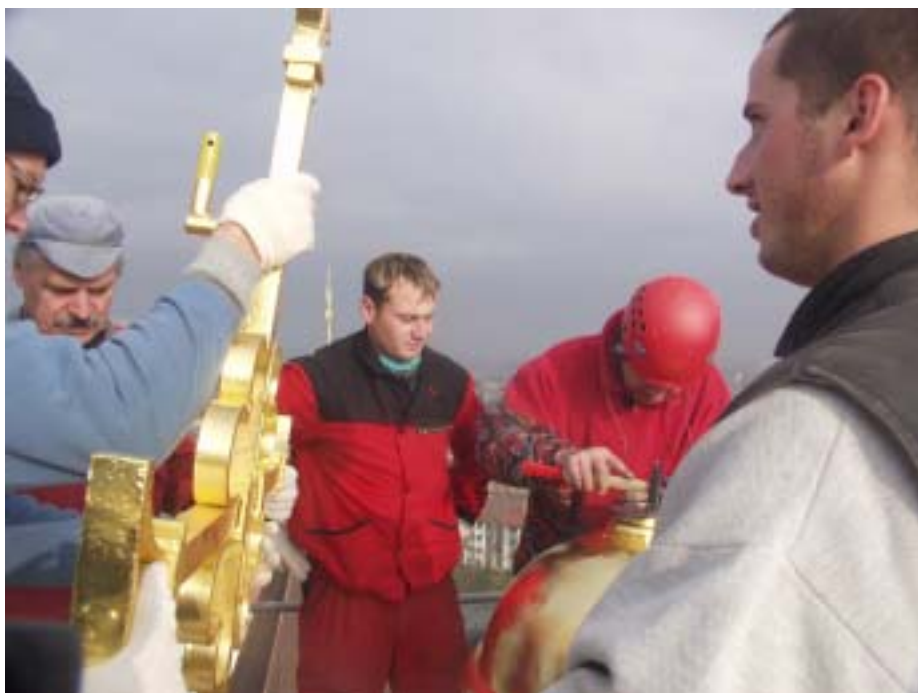
Na věži opravovaného kostela sv. Josefa byl v pátek 12. 11. 2004 osazen pozlacený kříž s bání. Do ní byly opět vráceny nalezené historické dokumenty. Foto: Erik Kluka
