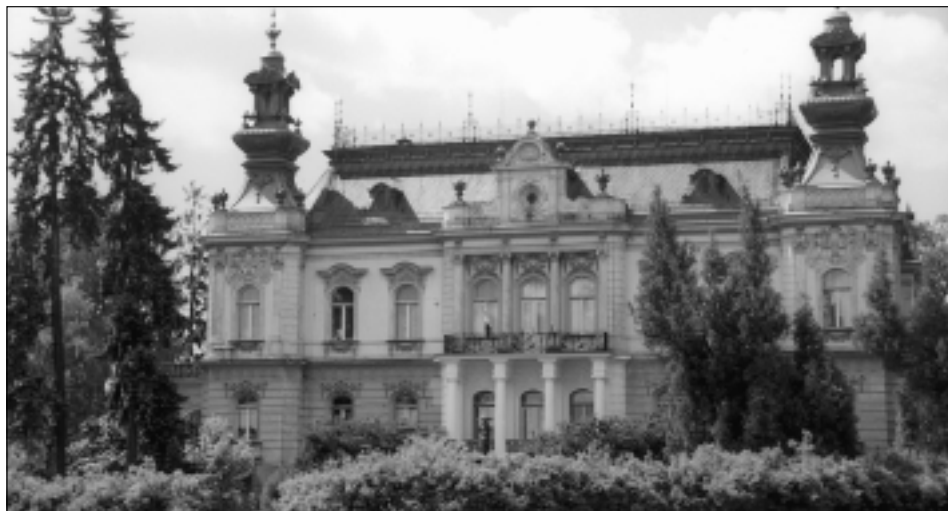
Langrova vila - opraveny již byly obě věže na čelní straně budovy i obě kratší strany střechy. Zbývá provést výměnu krytiny a oplechování na severní a jižní straně. Foto J. Čermák.
