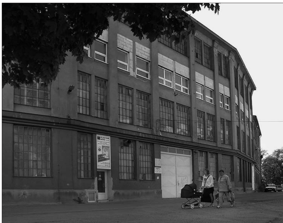
V objektu bývalé Vigony by v případě získání dotace z EU mohla vzniknout mimo jiné i nová knihovna. Foto: Erik Kluka - Noviny Svitavska
