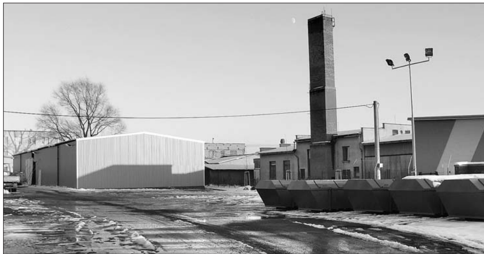
Rekonstrukce sběrného dvora stála 14 mil. Kč. V jejím rámci byla mj. postavena ocelová hala o rozměrech 40 x 15 m a výšce 4,5 m.
